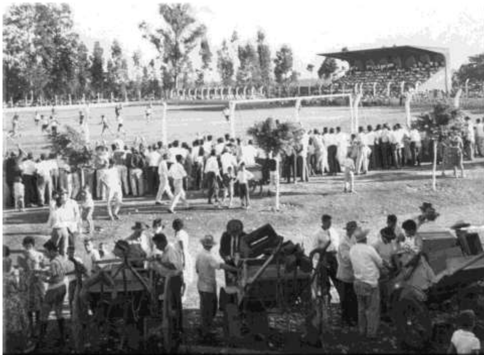
A diretoria do União Barbarense, na segunda gestão do presidente Pedro Récchia, construiu em seu estádio o primeiro lance de arquibancadas cobertas (capacidade para 860 lugares), em concreto armado, cujas obras haviam sido iniciadas em 1960 (na foto da época, uma tarde de jogo com o Estádio Antonio Guimarães completamente lotado)
