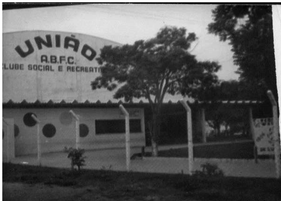
O Salão Social construído dentro do Clube de Campo unionista, com frente para a Rua dos Girassóis
